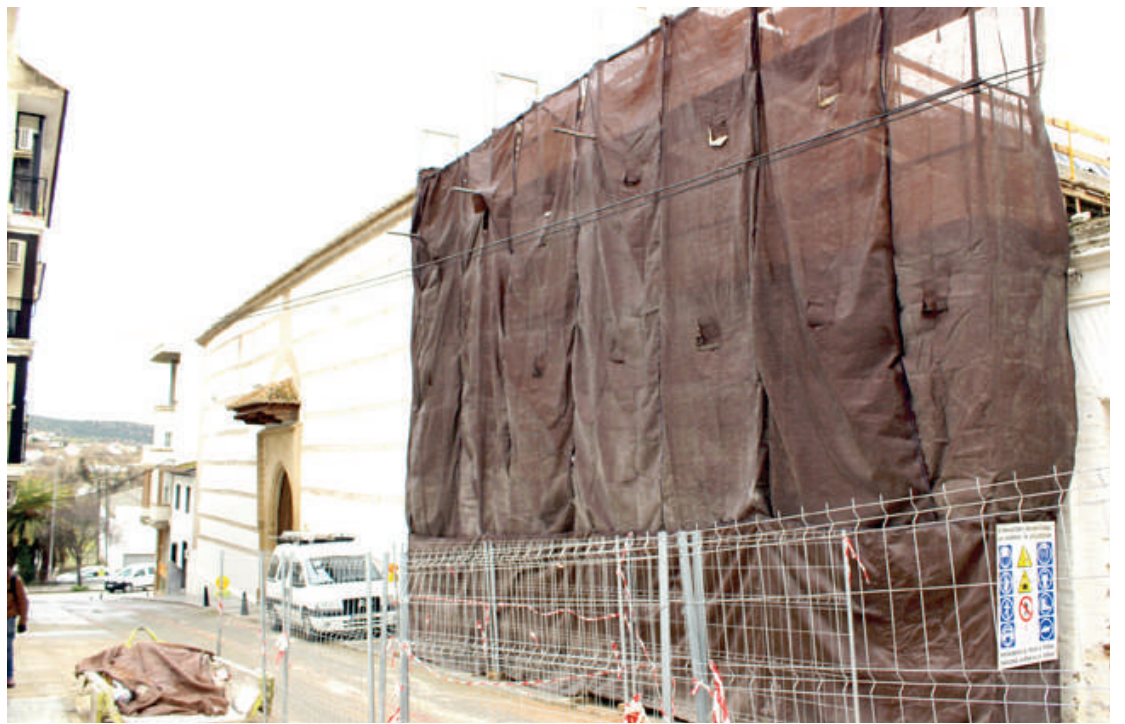
Desde hace dos meses se actúa, de manera urgente, en la consolidación de la estructura de la cubierta y el muro de la fachada de la zona anexa a los coros de la iglesia. Foto: Redacción.
