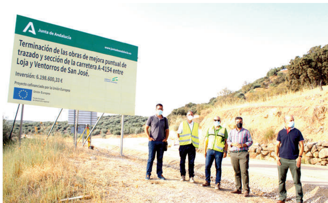
Autoridades políticas junto al director de la obra durante una reciente visita a la carretera de Ventorros. Foto: Redacción.
