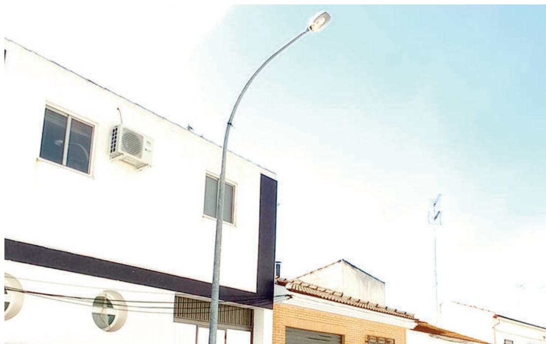
Del estudio previo se extrae que con esta actuación se disminuirá la potencia de 71.32 kW a 18.66 kW y un ahorro del 80%.Foto: Red
