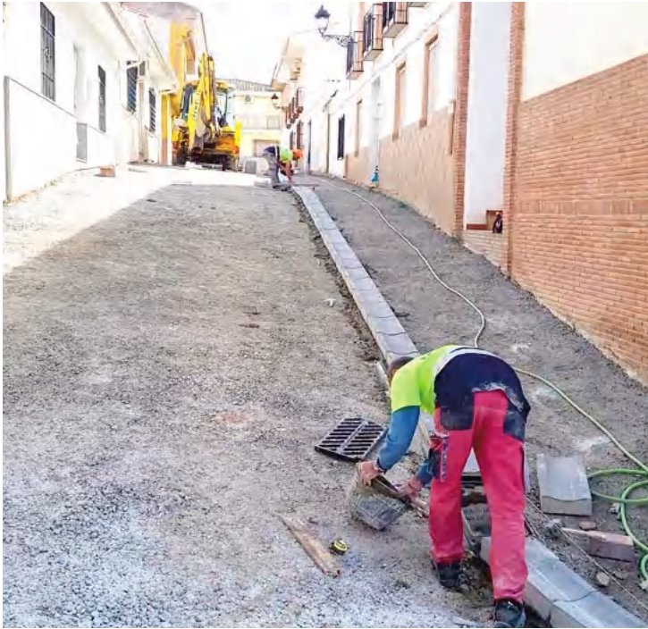
La inversión asciende a 20.000 euros y paralelamente se ha añadido una red de separación de agua de lluvia para verterla directamente en la cuenca del río, en lugar de que pase a la depuradora. Foto: Redacción
